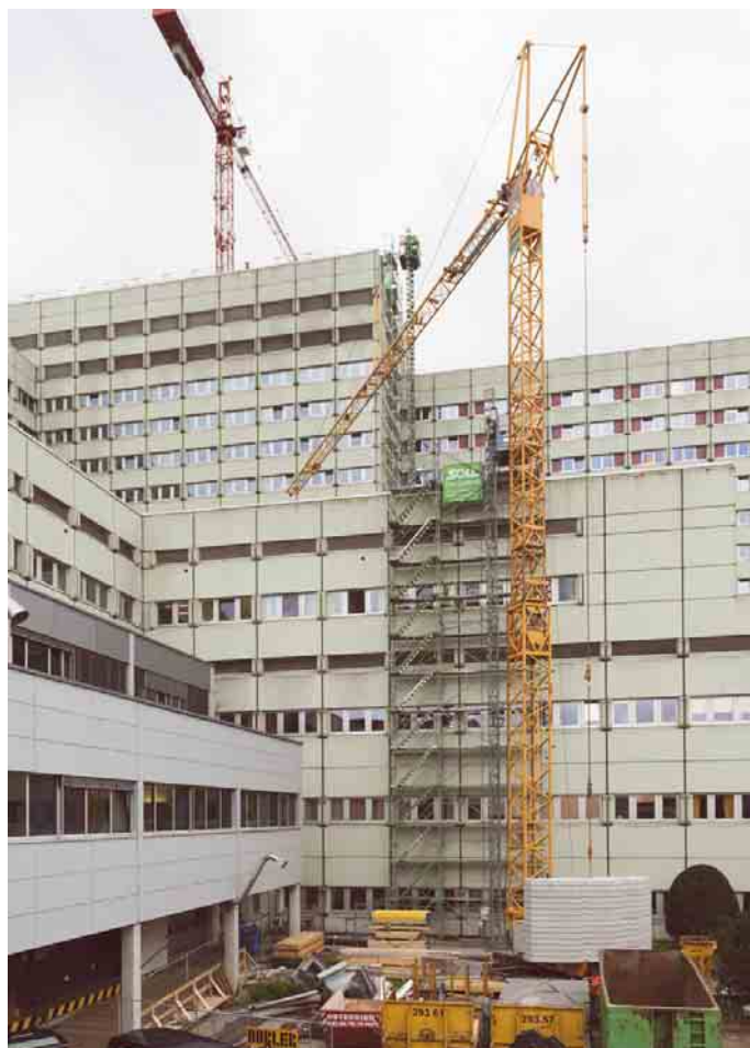
Für den Bau der Hubschrauberplattform auf dem Dach werden die vorgefertigten Teile vom Kran rechts erst auf das Dach des Vorbaus gehoben, dann hievt sie der andere zur Baustelle in 58 Metern Höhe.
