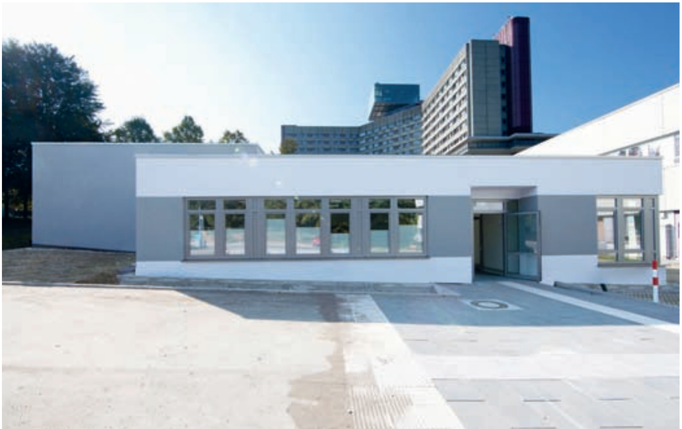
Ein direkter Zugang zum Ambulanzzentrum ist über eine eigene Zufahrt mit 15 Stellplätzen möglich.
