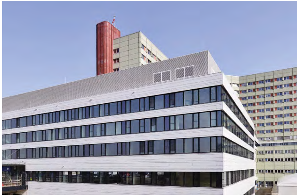
Der Anbau West ist die größte Einzelbaumaßnahme im Rahmen der Generalsanierung.
